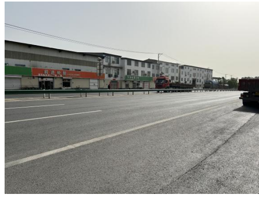
本项目所在厂区北侧新 310 国道
