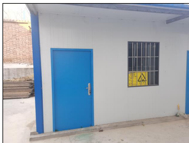
现有危废暂存间
