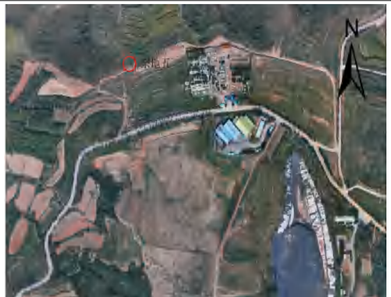
拟建 F05 风机处现状
