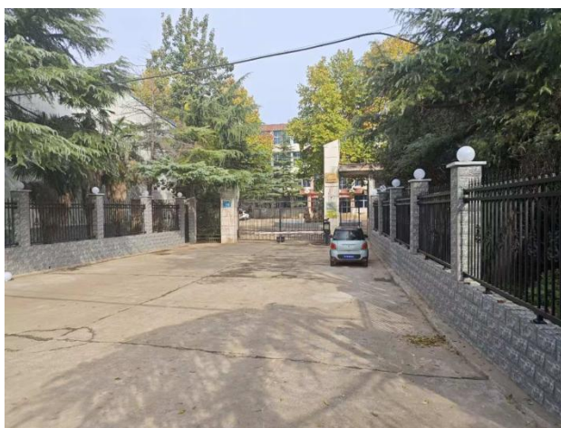
厂区西侧洛阳市孟津县麻屯精密铸造冶炼厂
