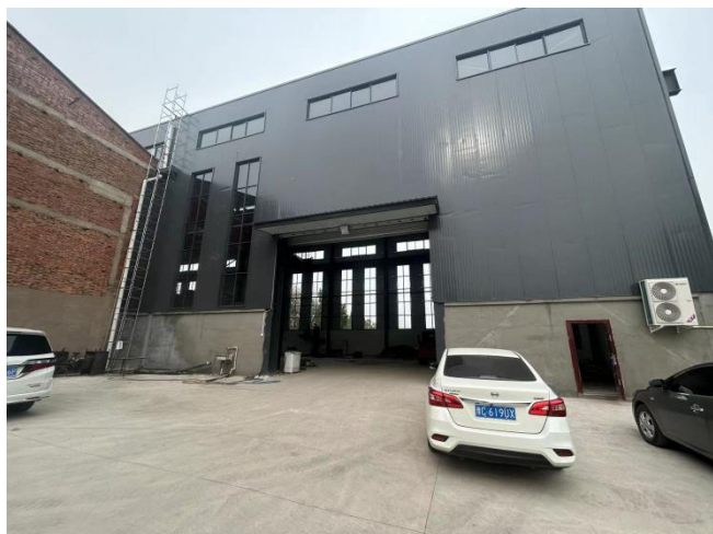
本项目租赁已建生产车间
