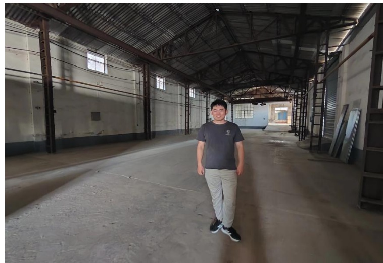
工程师踏勘现场照片
