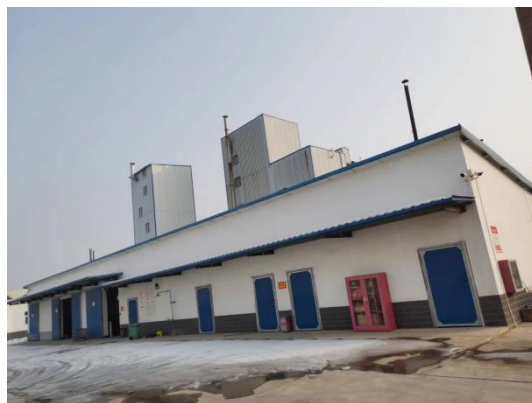
配气室、分析室、钢瓶处理间
