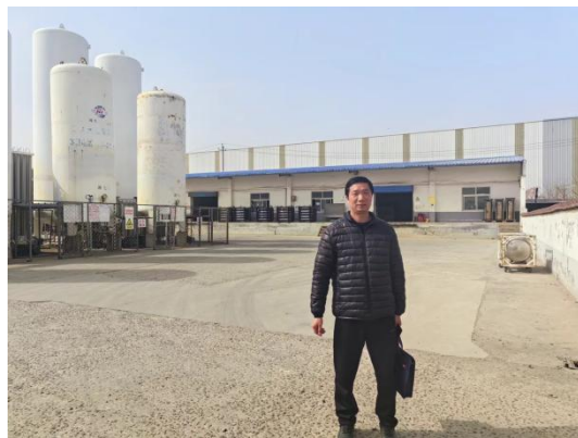
液氧、液氮等储罐区
