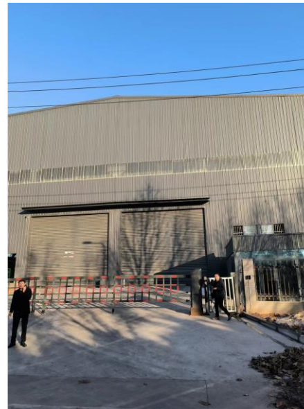
车间外景及厂区大门
