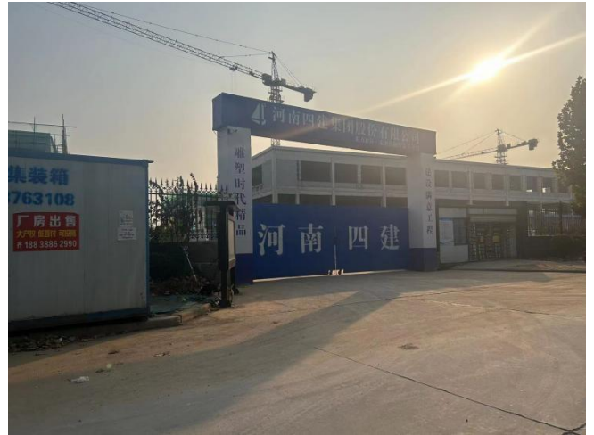
厂区北侧联东U谷项目基地
