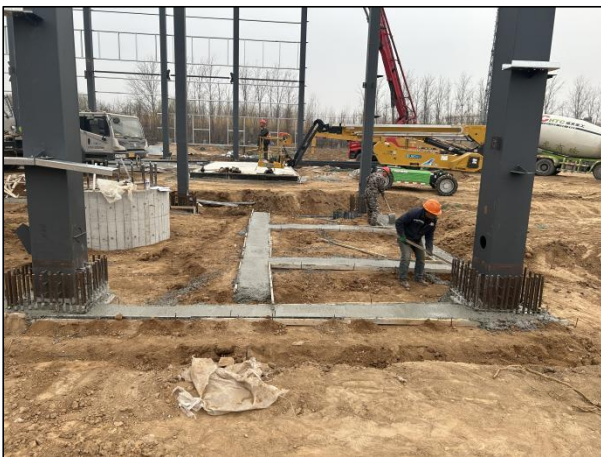
在建工程现场照片
