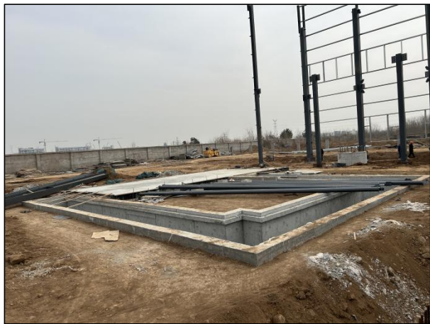
在建工程现场照片
