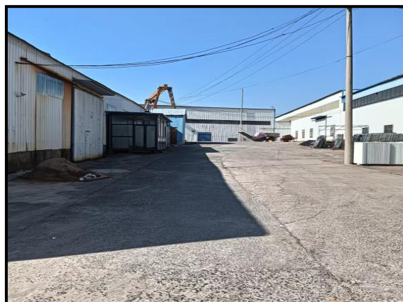
项目车间东侧厂区内道路
