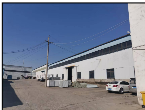
厂区车间北侧门窗加工厂
