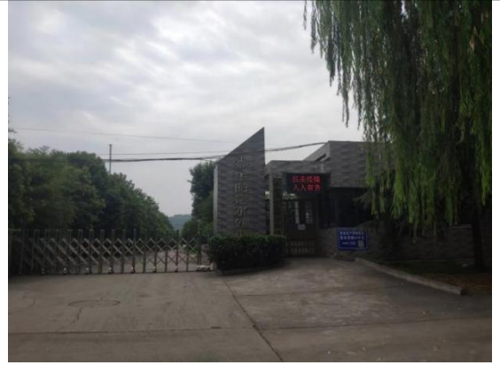
厂区西侧洛阳市华强经济建设投资有限公司 (原白鹤镇污水处理厂)
