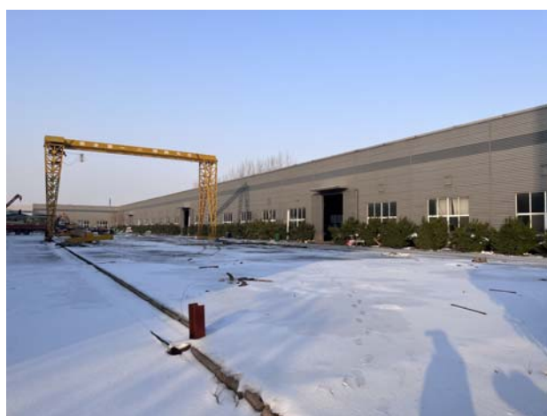
本项目租赁的 2#车间现状
