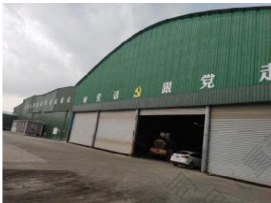
水泥管车间及破碎车间
