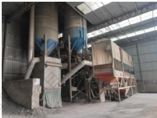
桥梁生产线及除尘器
