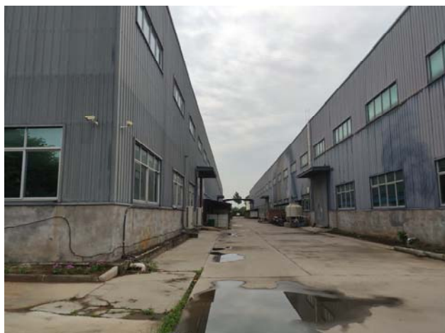
项目车间南侧道路及哈源企业车间
