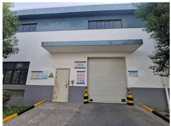
依托现有危废暂存间
