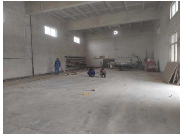
生产车间内部
