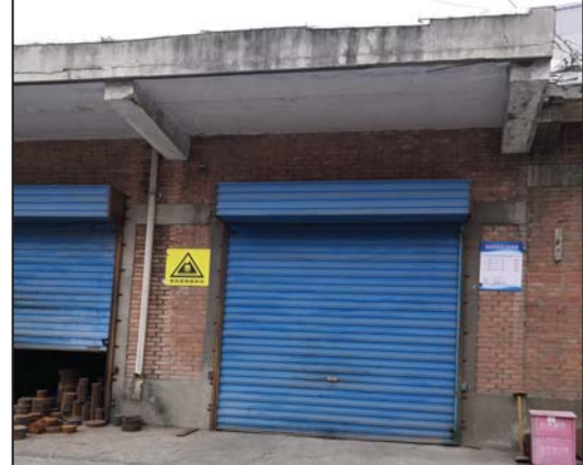
2#危废暂存间外部
