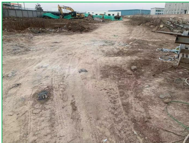
本项目 4#车间拟建地
