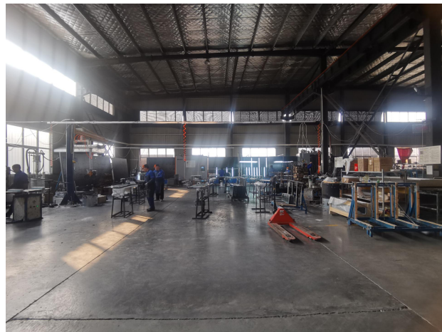
项目现有生产车间
