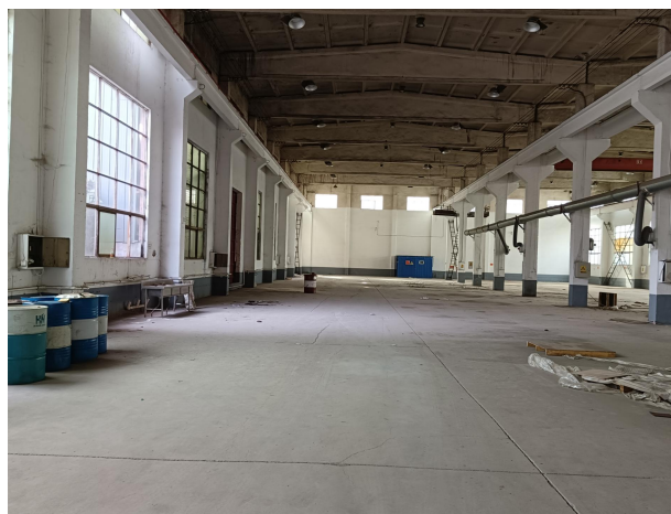
本项目生产车间
